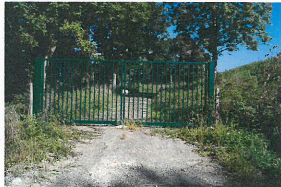
4 - Portail d'entrée Ouest (condamné)
