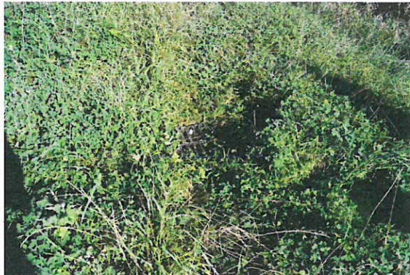
6 - Regard de collecte Nord
